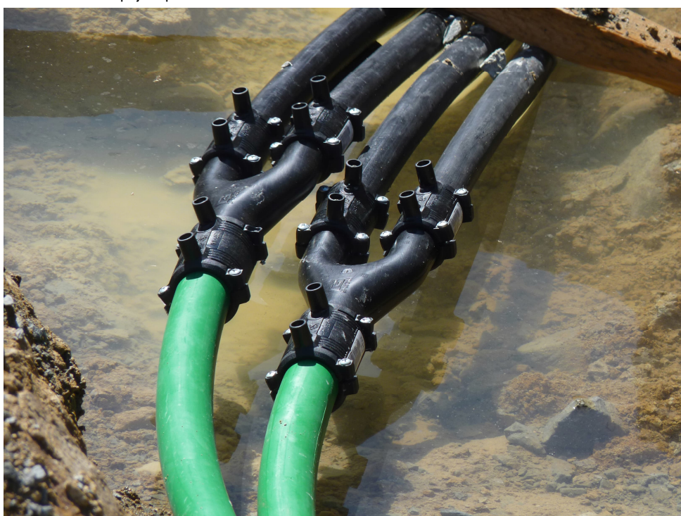
Obrázek č. 2 - Napojení pomocí Y-kusů
